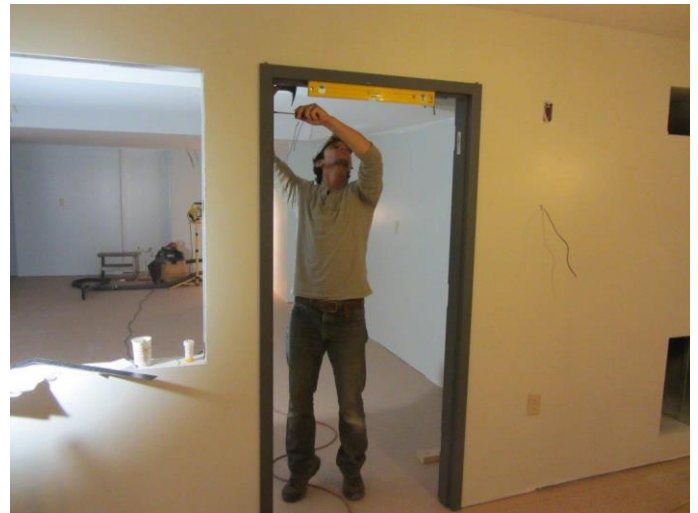
Installing door frames.
