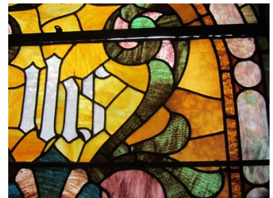
Gap due to sagging
