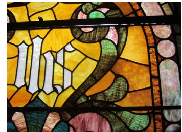
Gap due to sagging
